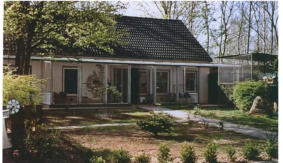
Das renovierte und ausgebaute Katzenhaus.
